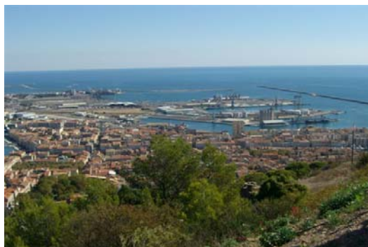
Vista general del Puerto de Sète
